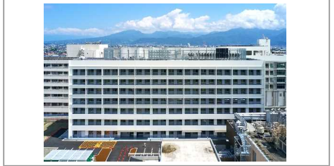
附属病院Ⅱ期棟
